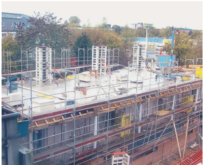
Sanierung, Modernisierung und Erweiterung 2004-2006
